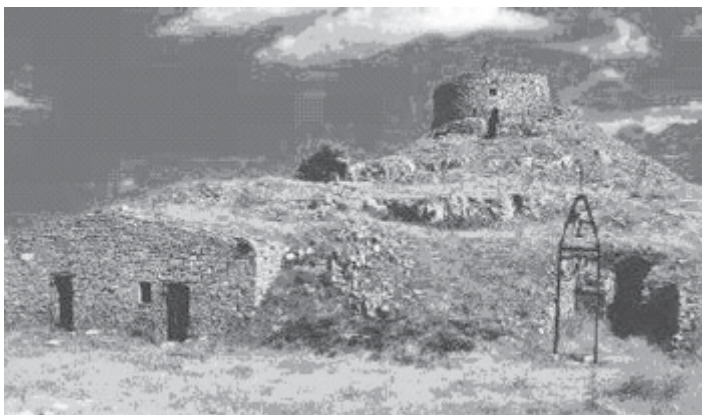
Vista della Torre e degli edifici giurisdavidici sul Monte Labro
